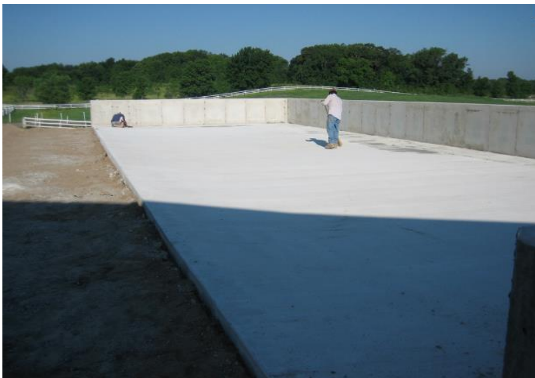
Εικόνα 19 : Βάση σκυροδέματος αποθήκευσης στερεών πρώτων υλών
