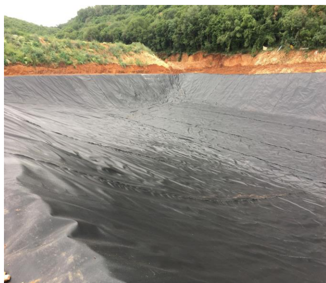
Εικόνα 29 : Ειδική μεμβράνη (geotextile) βάσης λιμνοδεξαμενής για την στεγανή αποθήκευση του παραγόμενου υγρού χωνεμένου υπολείμματος και ενδεικτική τοποθέτηση από άλλο έργο
