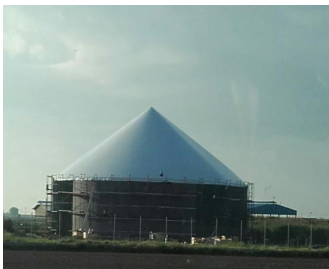
Εικόνα 24 : Άνω μεμβράνη PVC – προστασίας καιρικών φαινομένων (ενδεικτική φωτογραφία)
