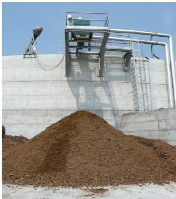
Εικόνα 28 : Προτεινόμενο σύστημα διαχωριστή (τύπου screw-press)
