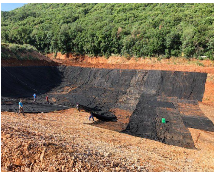
Εικόνα 29 : Ειδική μεμβράνη (geotextile) βάσης λιμνοδεξαμενής για την στεγανή αποθήκευση του παραγόμενου υγρού χωνεμένου υπολείμματος και ενδεικτική τοποθέτηση από άλλο έργο
