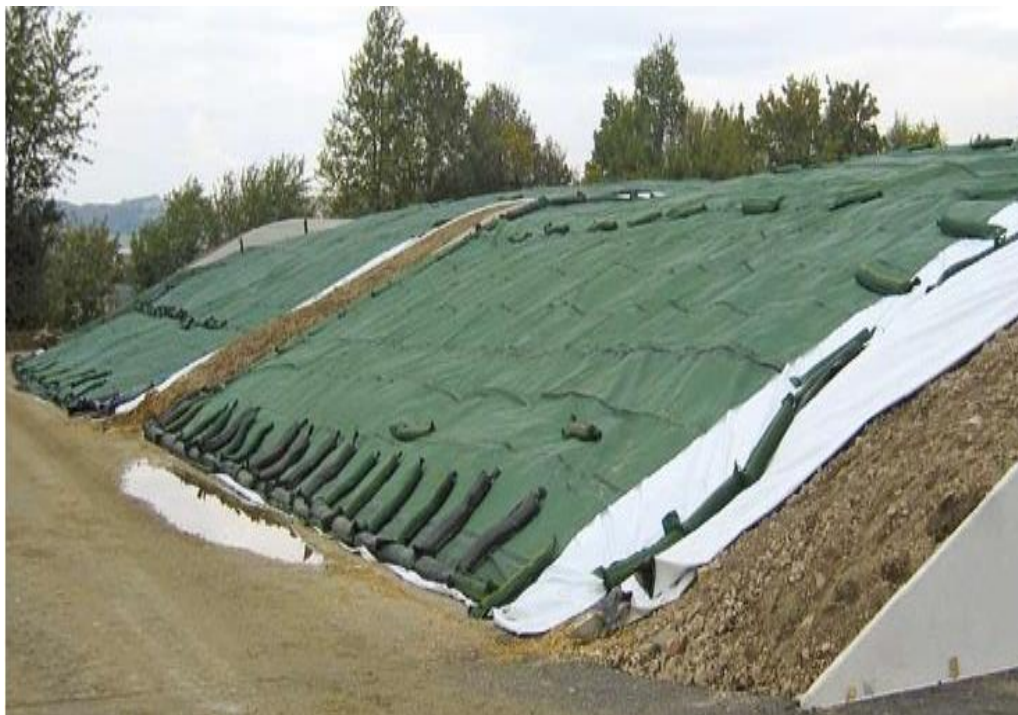
Εικόνα 20 : Ενδεικτική εικόνα για την κάλυψη σωρών στερεής κοπριάς
