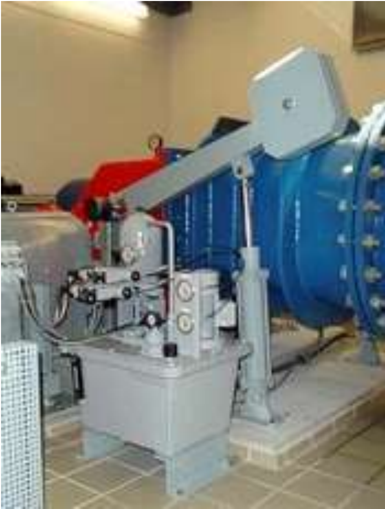
Εικόνα 24: Άποψη του μηχανικού συστήματος ελέγχου και του υδραυλικού συστήματος με το αντίβαρο
