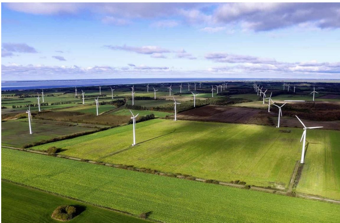
Εικόνα 9.4: Αιολικό πάρκο στην Δανία, Rejsby Hede (Πηγή: https://jv.dk )
