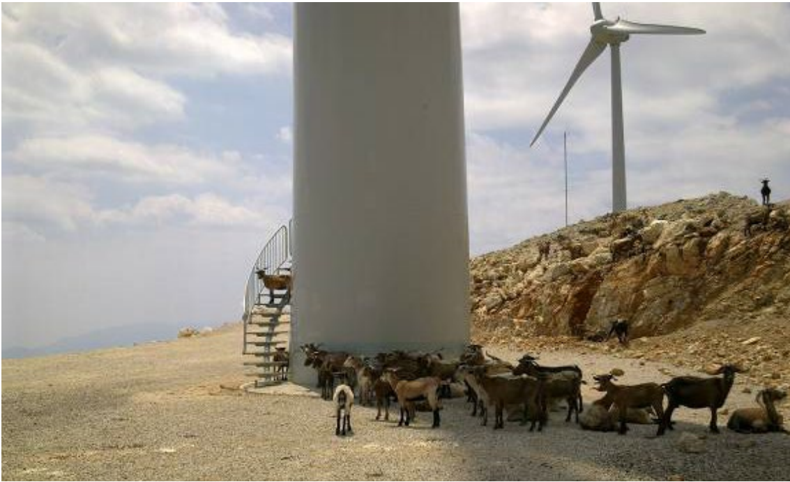
Εικόνα 9.6: Αιολικό Πάρκο της ΕΛΛΑΚΤΩΡ Α.Ε. στην Περιφερειακή Ενότητα Αργολίδας.
