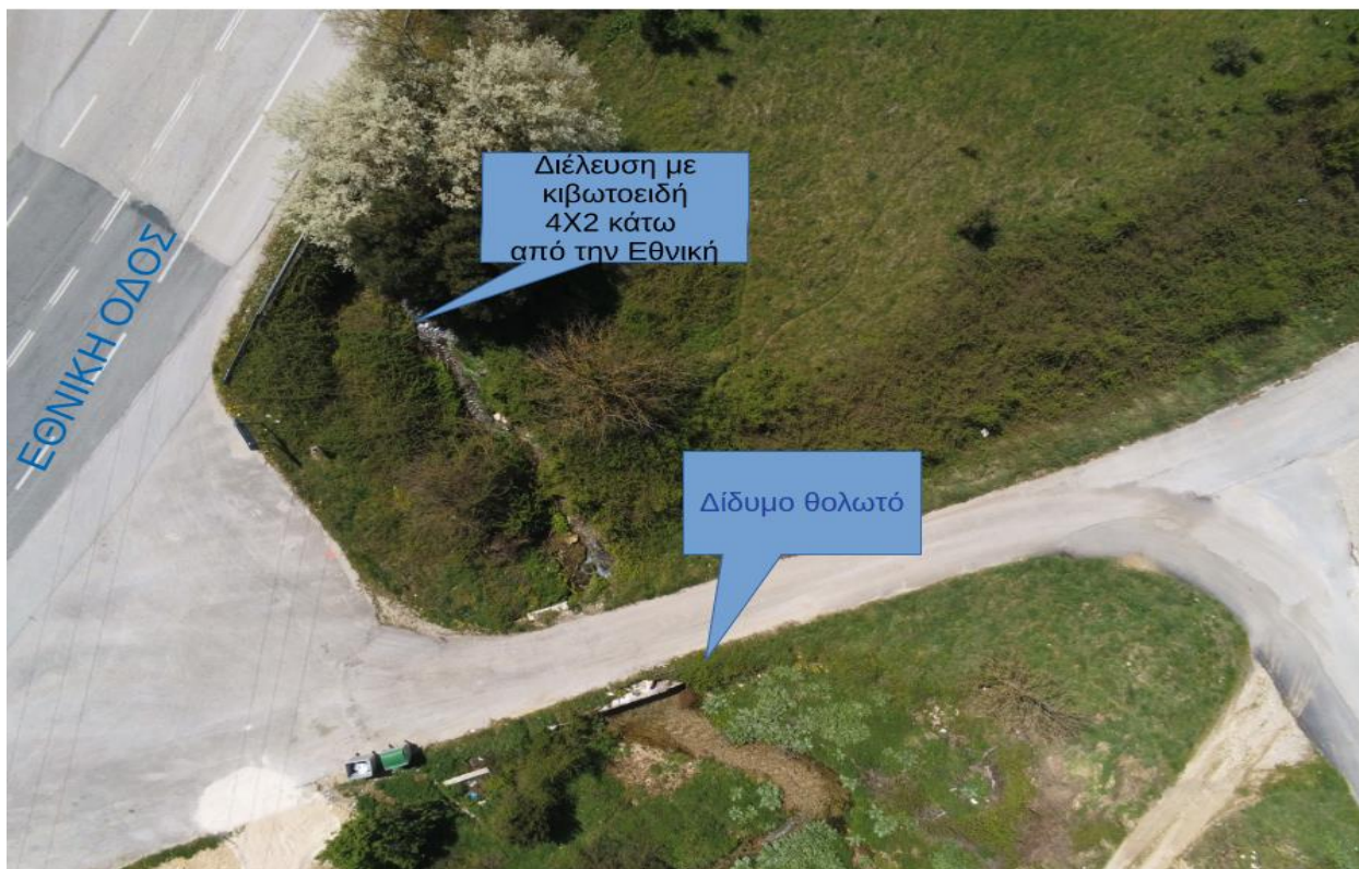
Εικόνα 17: Αποτύπωση υφιστάμενης κατάστασης (κιβωτοειδής οχετός στην συμβολή του χειμάρρου με την Ε.Ο.)
