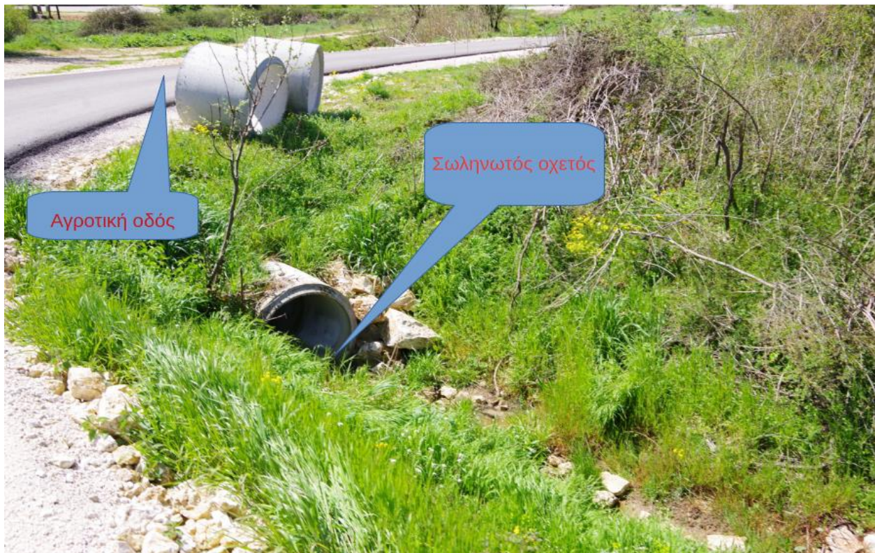
Εικόνα 19: Αποτύπωση υφιστάμενης κατάστασης (υφιστάμενος σωληνωτός οχετός)
