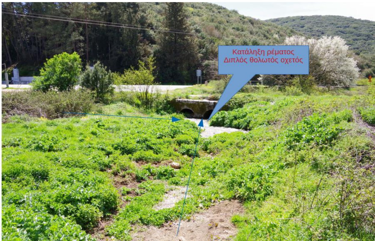
Εικόνα 16: Αποτύπωση υφιστάμενης κατάστασης (κατάληξης ρέματος σε διπλό θολωτό οχετό)
