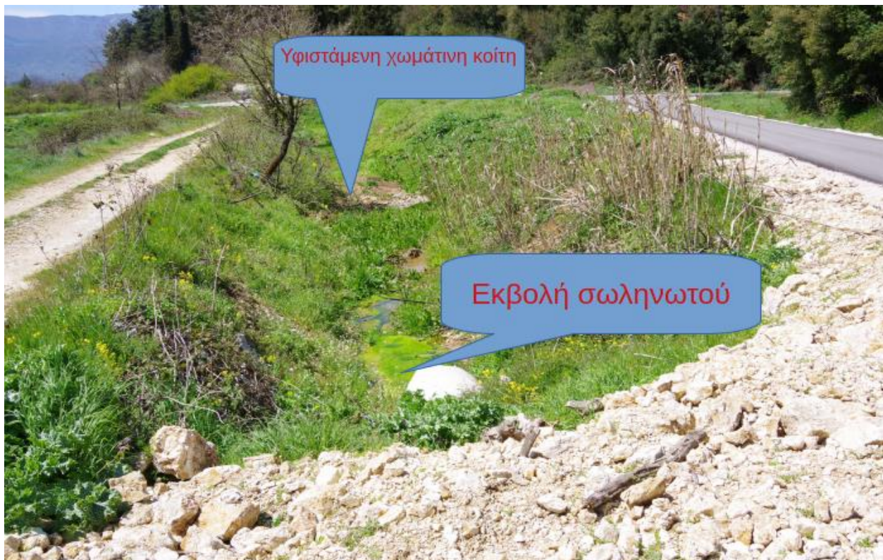
Εικόνα 20: Αποτύπωση υφιστάμενης κατάστασης (εκβολή σωληνωτού οχετού και υφιστάμενη κοίτη ρέματος)
